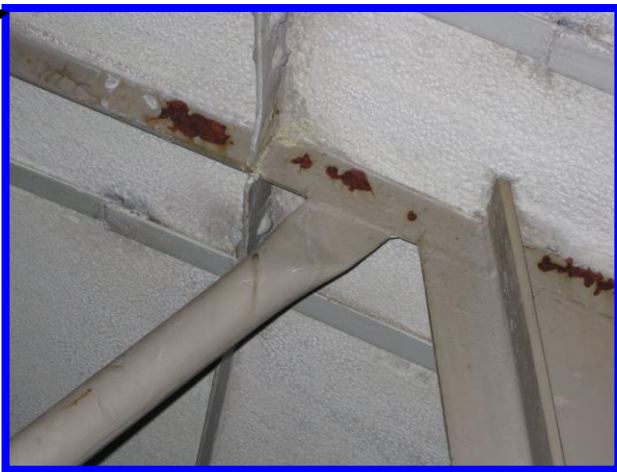
トラスNo.4 ラチス材正常部位
