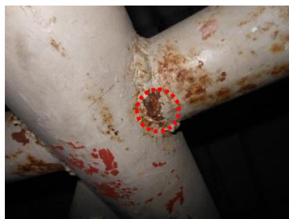
⑦ 下弦材No.7とリング材の溶接部
