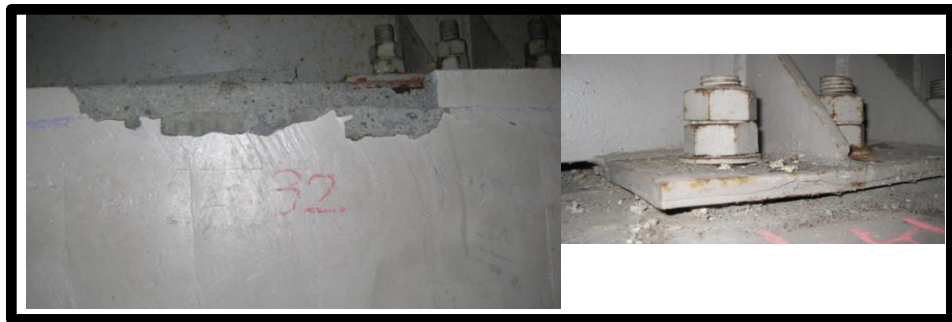
コンクリート躯体部の補修 (ベースプレートを含む)
