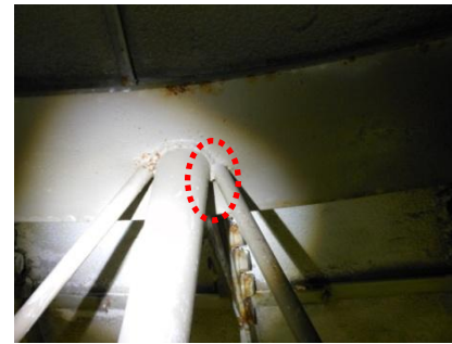
③ 頂部リングとラチス材の溶接部 (上弦材No.34付近)
