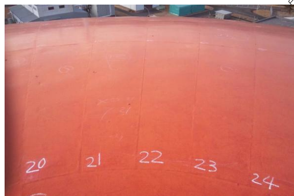
中央部付近鉄板
