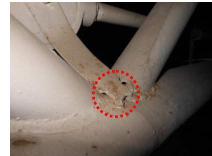
⑨ 下弦材No.15とラチス材の溶接部
