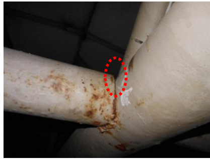
① 下弦材No.30のリング材溶接部
