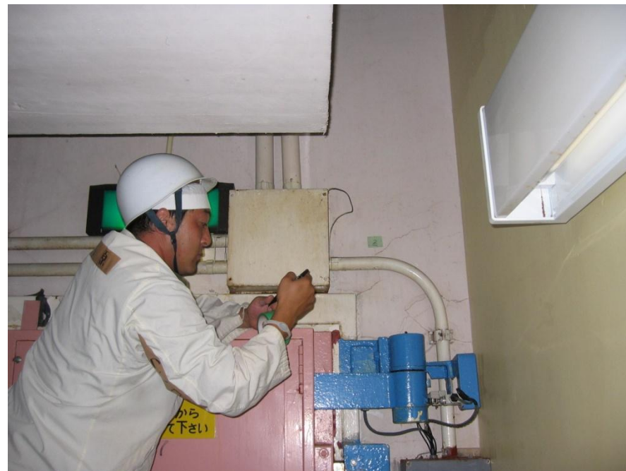
コンクリートひび割れ調査
