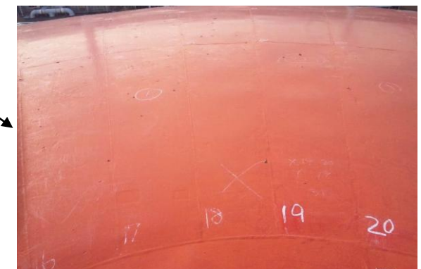
中央部付近鉄板
