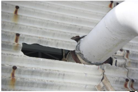
排風機室外壁(波板スレート)破損
