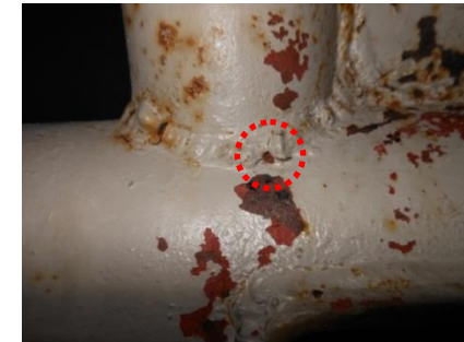
⑧ 下弦材No.9とリング材の溶接部
